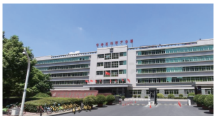
华业科技园实验室
